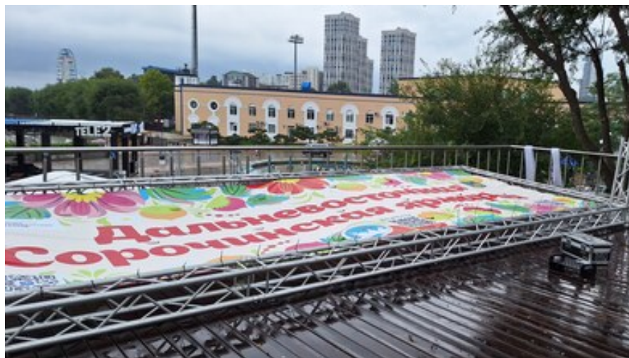
Установка задника сцены
